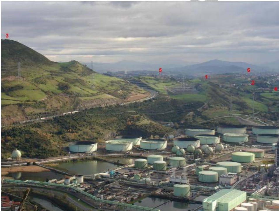
Misma panorámica tomada desde la cumbre del Janeo hacia el campo carlista. Hoy en día el paisaje está profundamente transformado por las instalaciones de Petronor y por la A8.
