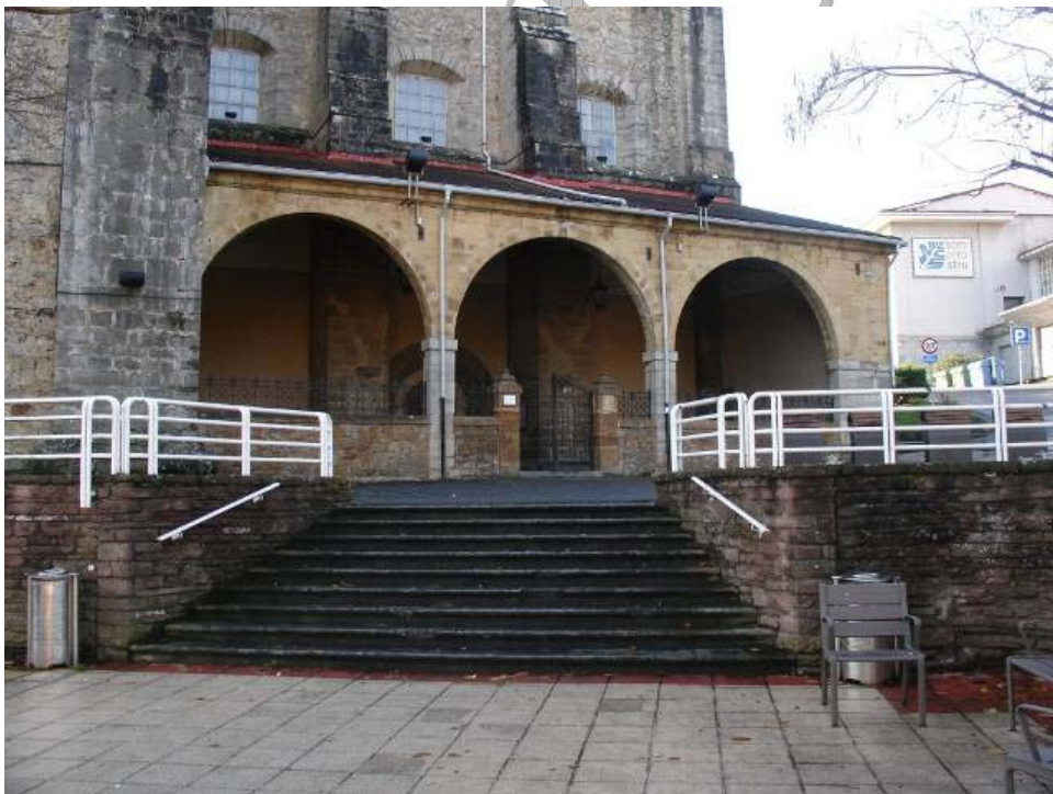
Vista actual del pórtico de la Iglesia de San Juan en cuyo tejado se incendió a causa de la explosión de un carro de municiones el 19 de marzo de 1874. Esta iglesia, después de utilizarse como hospital de sangre fue utilizada como polvorín y depósito de municiones
