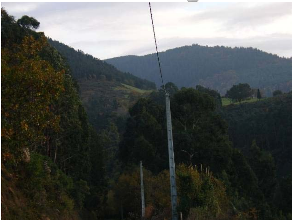
Detalle del "Portillo de Cortes" desde la vía del ferrocarril de Galdames.
